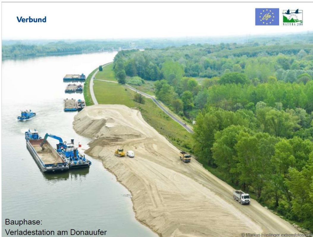
Abb. 8: Verladearbeiten am Donauufer. Kies wird aus der LKW- Anschüttung auf Schiffe geladen. Abtransport der Kiesmengen umweltfreundlich per Schiff. Der Kies wird stromab des Donaukraftwerks Freudenu der Donau zugegeben.
