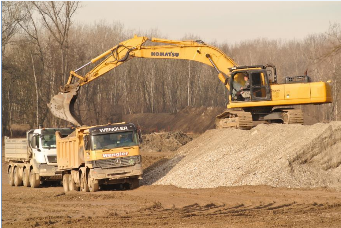
Abb. 7: Ausgehobener Kies wird zum Abtransport aufgeladen
