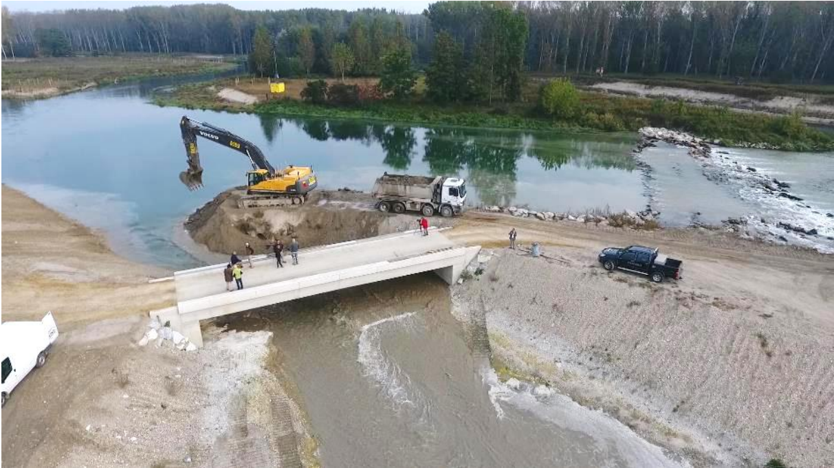
Abb. 20: Durchstich und damit Anbindung des BA 3 am 26/09/2016. Der Traisen-Fluss wird zur neuen Mündung umgeleitet (Foto Pock).
