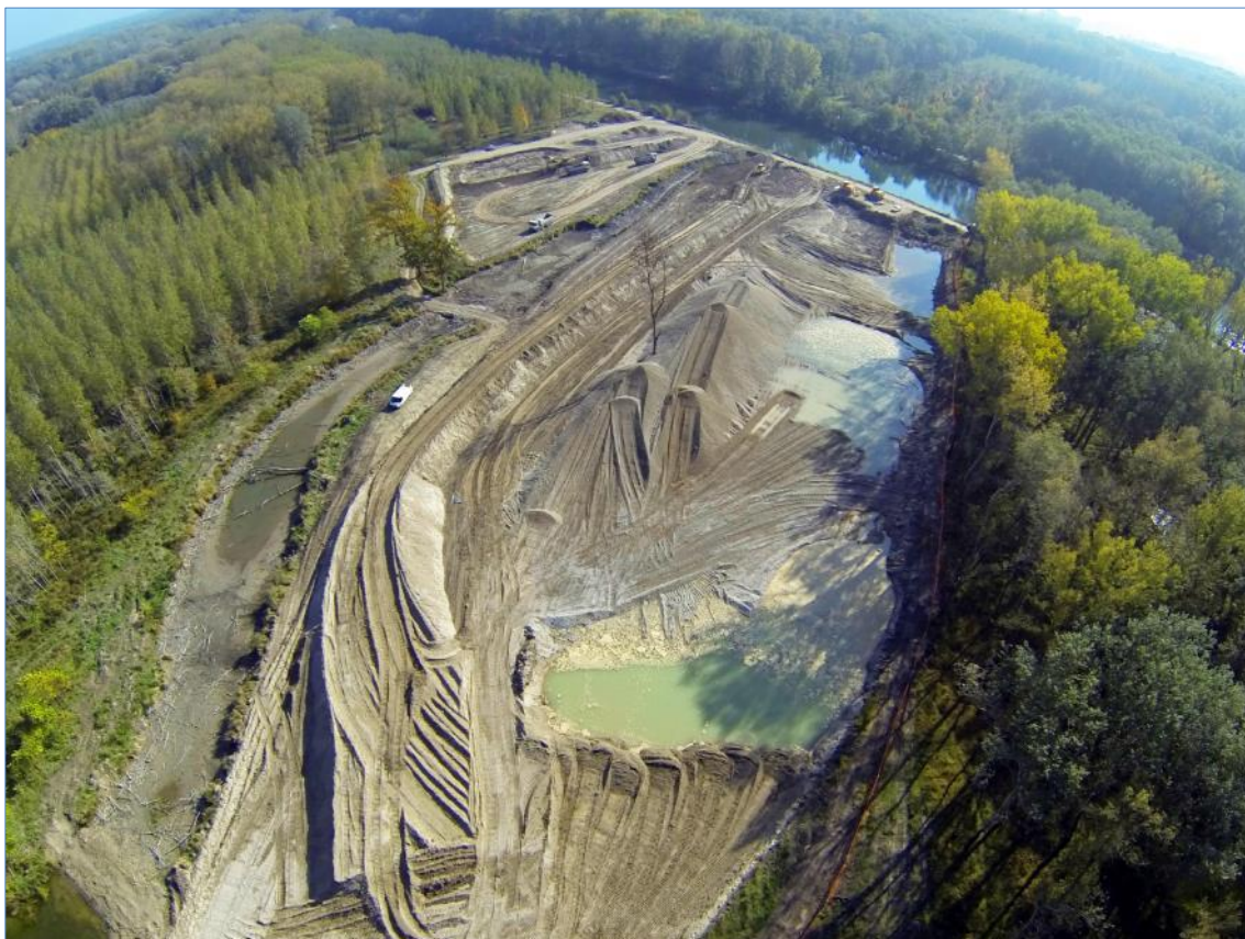
Abb. 6: Beginn der Aushubarbeiten. Deutlich zu sehen sind die seitlich weggeschobenen Au-Sandmengen und die ersten Gruben aus denen Kies entnommen wurde.
