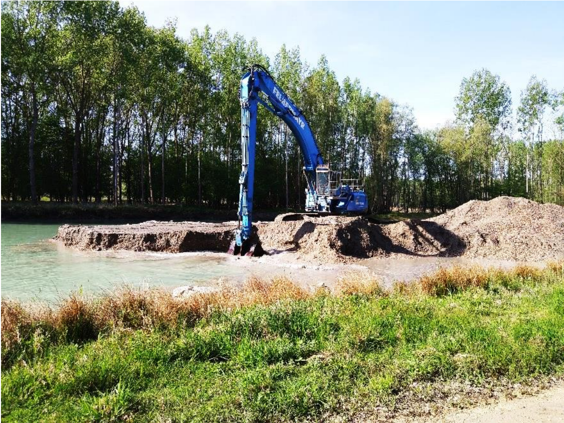
Abb. 26 Aushub eines Auweihers (Foto ezb)
