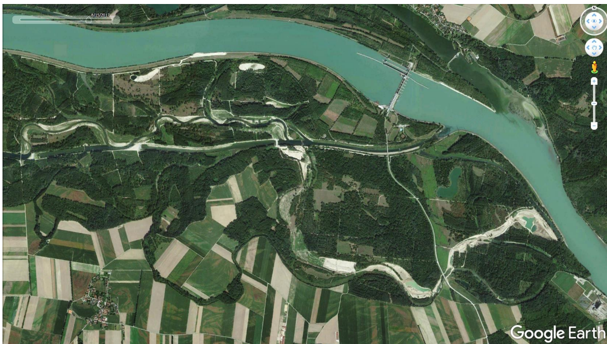
Abb. 29: Baustelle der neuen Traisen aus Google Earth im August 2017
