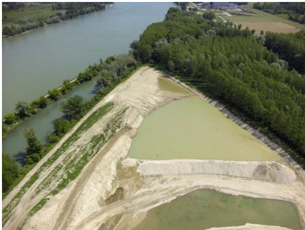
Abb. 16: Aushub von Kies und beginnende Verfüllung der Umlandabsenkung im mündungsnahen Bereich des BA Ost (FI-Km 0,4) am 2.7.15 (links) und Korridor mit teilausgehobener Umlandabsenkung bei der Querung der Eisteiche bis mündungsnaher Bereich am 2.7.15 (rechts, Fotos G.Pock)
