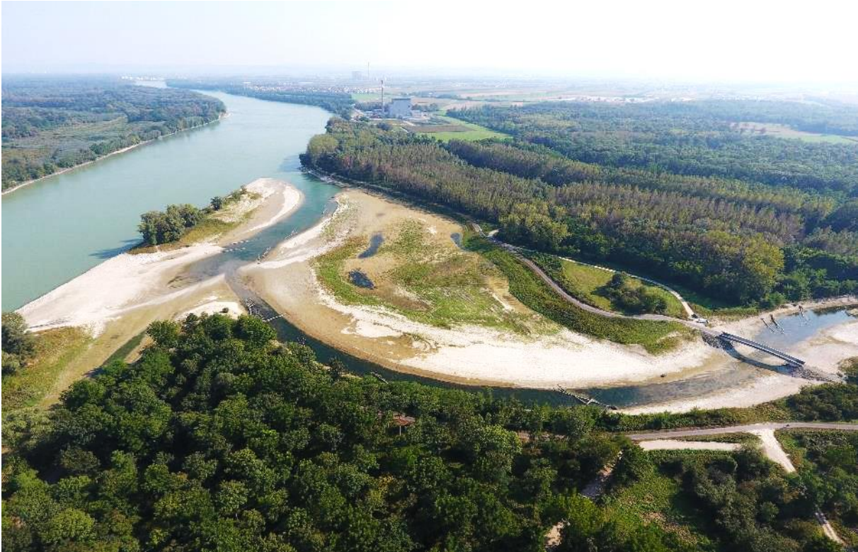
Abb. 23: Die neue Traisen-Mündung im September 2016 bei niedrigem Donauwasserstand. (Foto Pock).
